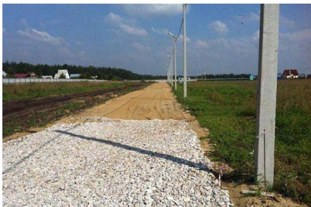
**Рис. 8.** Применение измельченного бетона при строительстве дорог [17]
