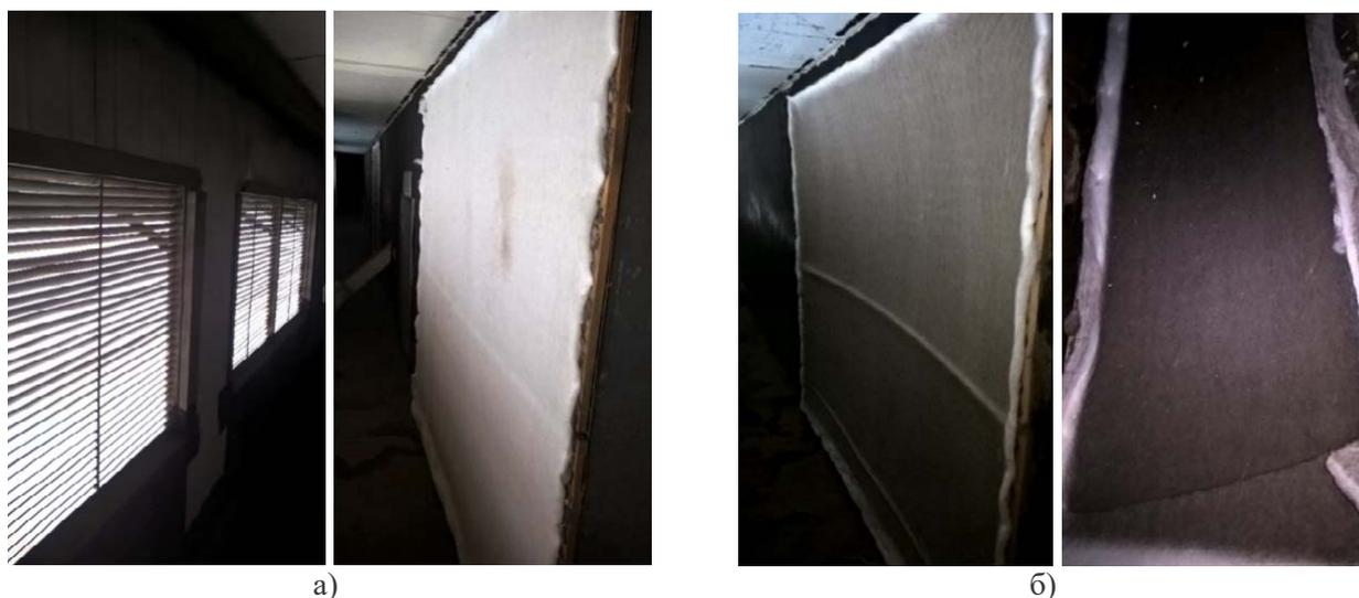
**Рис. 2.** Фильтрующий материал на входе в приточную установку
