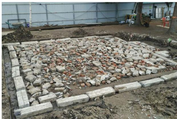
**Рис. 9.** Использование битого кирпича в качестве фундамента [17]
